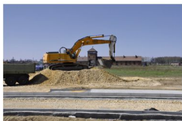
Jeszcze kilka miesięcy temu nie zwiastowało problemów z budową drogi odbarczającej w Brzezince. Fot. LCh
