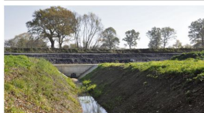
Pławy: wylot przebudowanego przepustu wałowego. Fot. LCh
