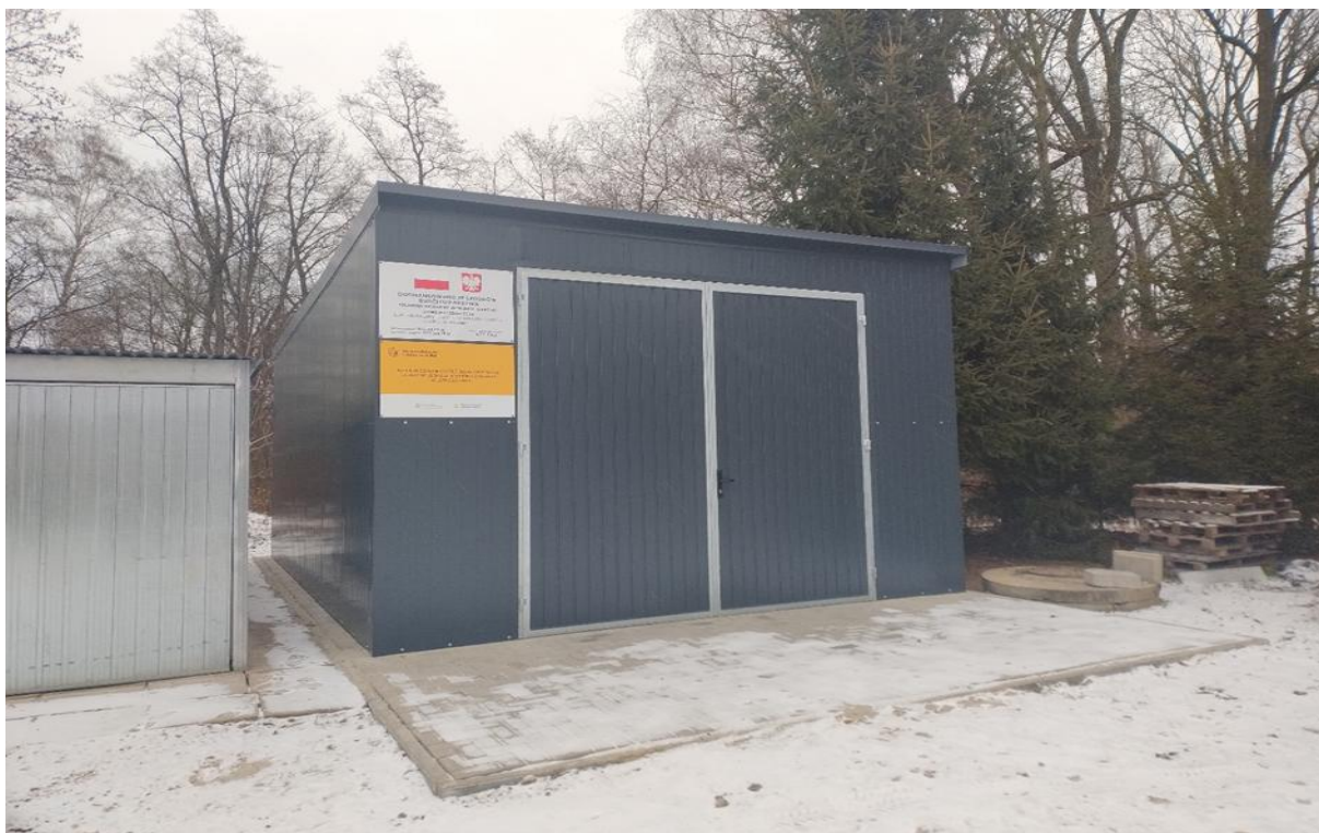
Fot.V.4. Magazyn w Harmężach
